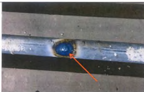
Фото№8. Устранения протечки с помощью сварки
