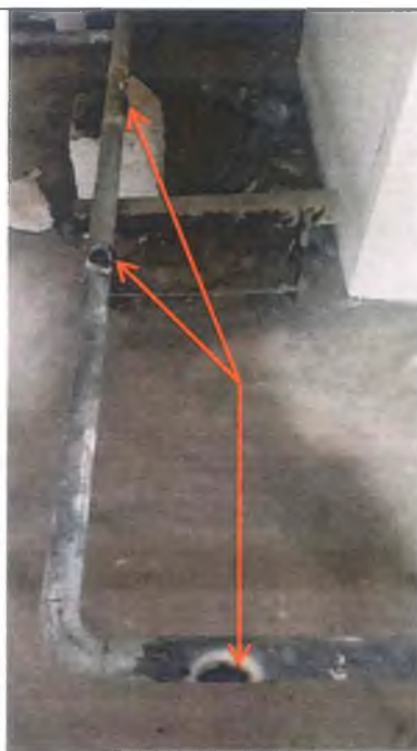
Фото №14. Устранение нескольких протечек с помощью сварки на чердаке
