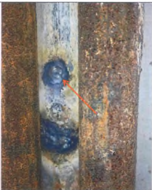
Фото№9. Устранение протечки с помощью сварки на главном стояке секции
