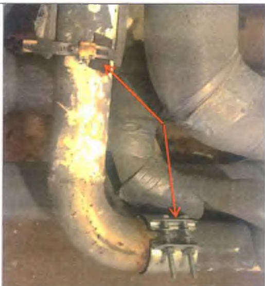
Фото№7. Устранение протечек трубы с помощью хомутов
